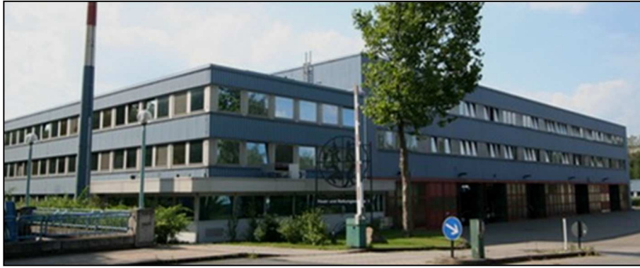
Abbildung 9 Feuer- und Rettungswache 1, Brücktorstraße 13
